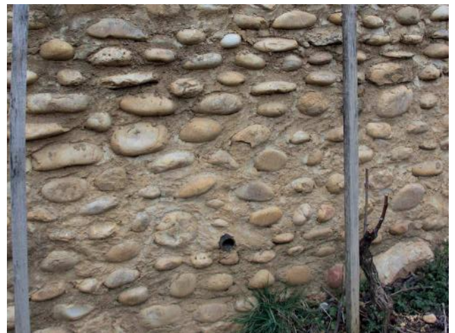
Les murs de soutènement en galets parement (Fiche 2.c bis)
