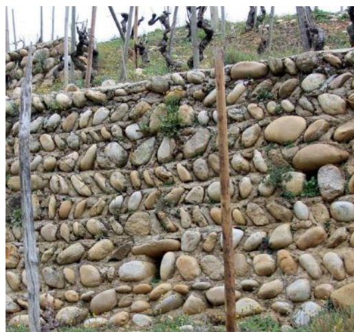
Mur en galets
