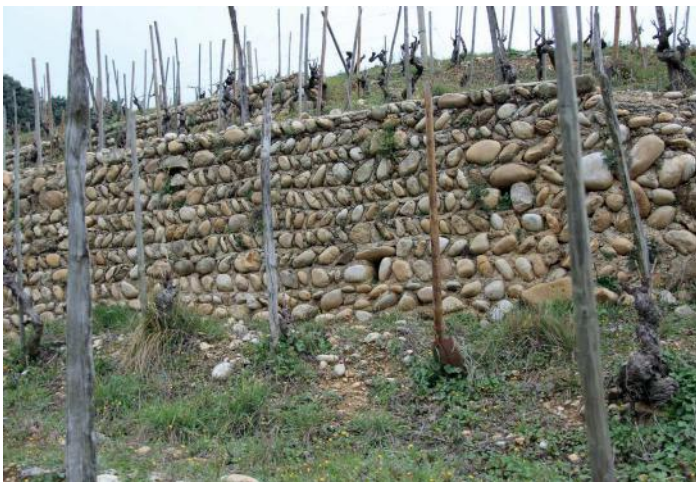
Les murs de soutènement en galets hourdés (Fiche 2.c)
