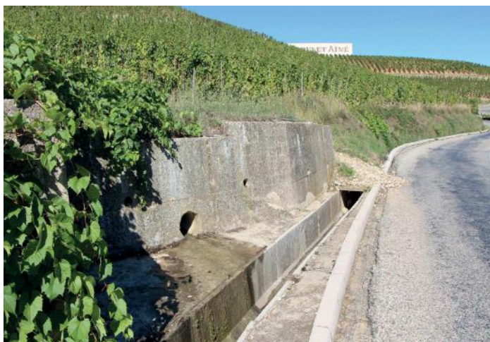
Aménagement hydraulique en bordure de route, au premier plan du vignoble
